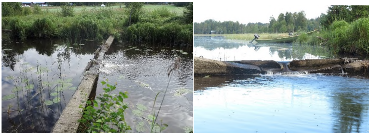
Bild: Tidigare betongtröskel
