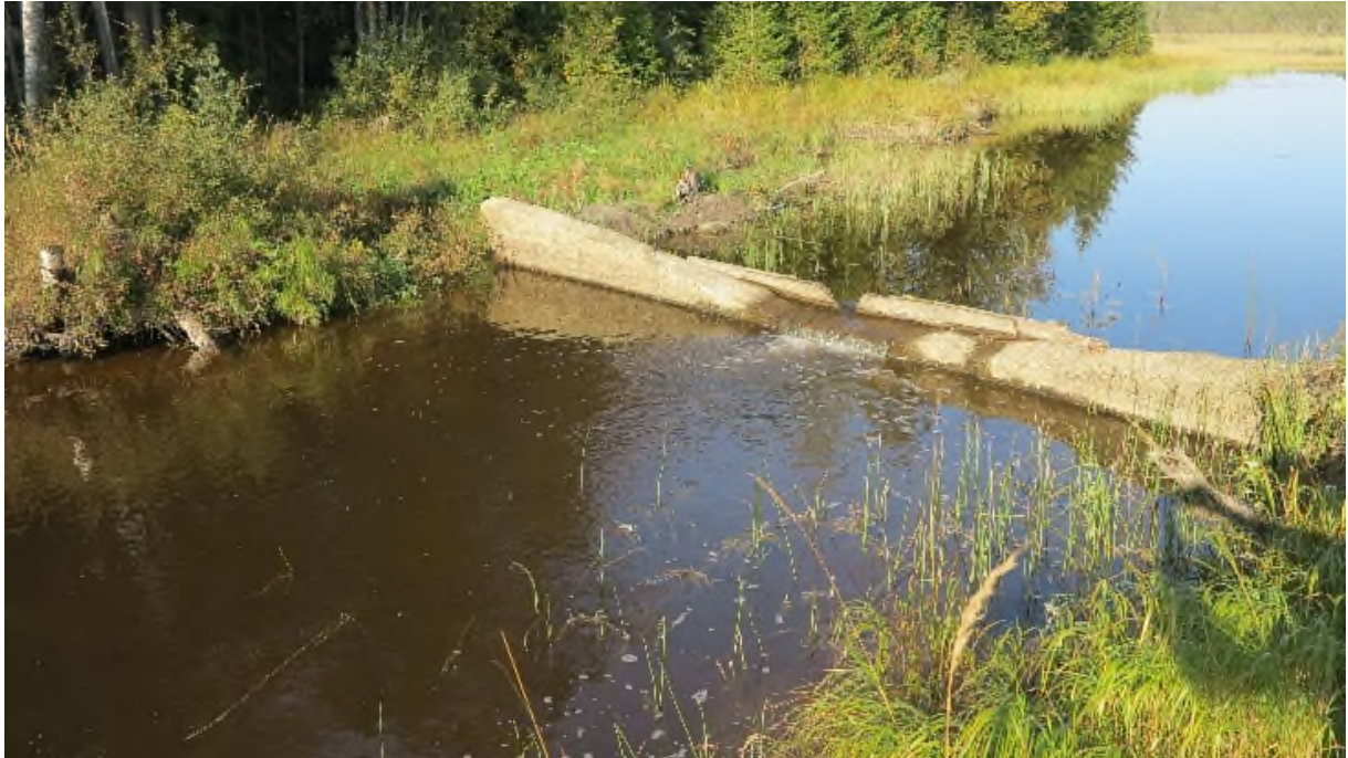
Bild: Före åtgärd 2014-09-13
