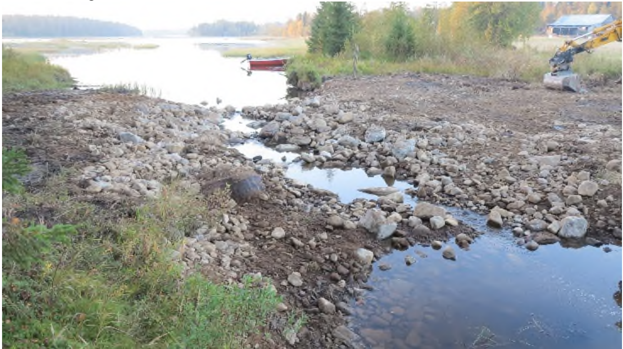
Bild: Efter åtgärd 2014-09-13
